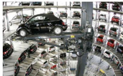
Car Towers Autostad, um estacionamento vertical de 48 metros de altura, com capacidade para abrigar cerca de 400 automóveis, localizado em Wolfsburg, na Alemanha, ele é composto por duas torres circulares de 20 andares, onde utilitários são levantados por braços robóticos e estacionados nas vagas
